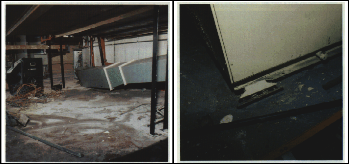
Şekil 5.5 Sağ üstte Havalandırma kanalları deprem sonucu devrilmiş durumda, sol üstte ise chiller ünitesi sadece titreşim sönümleyici yaylarla sabitlendiği için yay ayakları kırılmış durumda.
