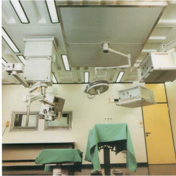
Şekil 4: Ameliyat Masası Aydınlatması Entegre Edilmiş Laminer Akış Ünitesi (Bölüntülü – İki Parçalı Tip)
